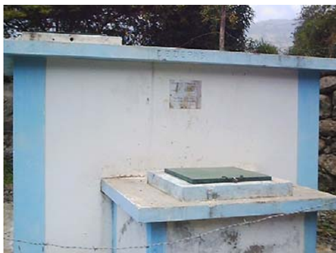
Reservorio de Agua Potable/El Palto
